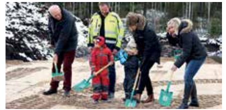
På Bäckaskogsområdet ska en ny förskola byggas.
